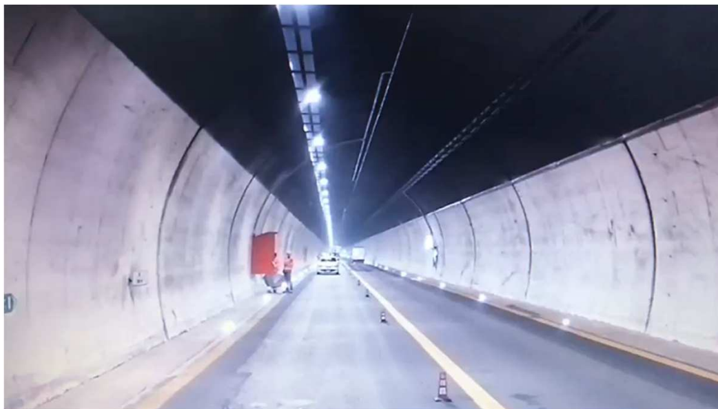
Prova di scarica
